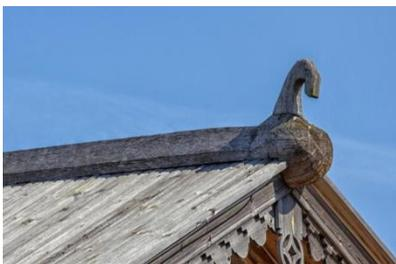
**Конек** - горизонтальное ребро, образуемое пересечением двух скатов кровли.
