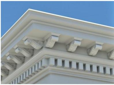
**Карниз** - выступающий элемент внутренней и внешней отделки зданий, помещений. В архитектуре карниз отделяет плоскость крыши от вертикальной плоскости стены, или разделяет плоскость стены по выделенным горизонтальным линиям.
