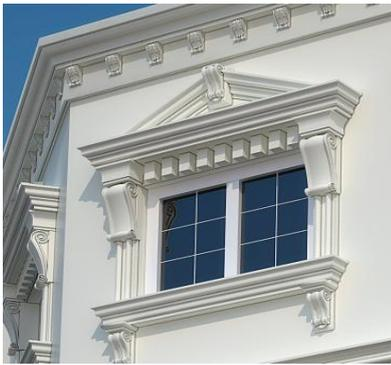
**Сандрик** — Архитектурная деталь в виде небольшого карниза или карниза с фронтоном разнообразных форм (треугольных, овальных и сложных композиций) над оконным, дверным проёмом или нишей.
