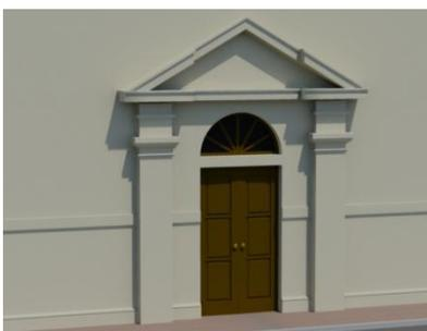
**Пиләстр** - вертикальный выступ стены, обычно имеющий базу и капитель, и тем самым условно изображающий колонну. Пиләстра часто повторяет части и пропорции ордерной колонны, однако, в отличие от неё, обычно лишена энтазиса (утолщения ствола).
